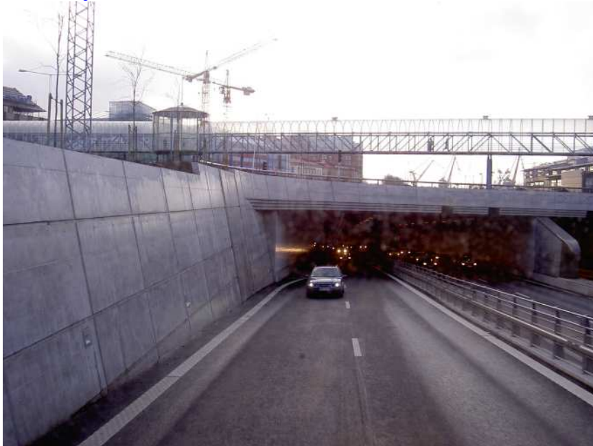
Ut från den nya tunneln mot Göteborg - Lappland
